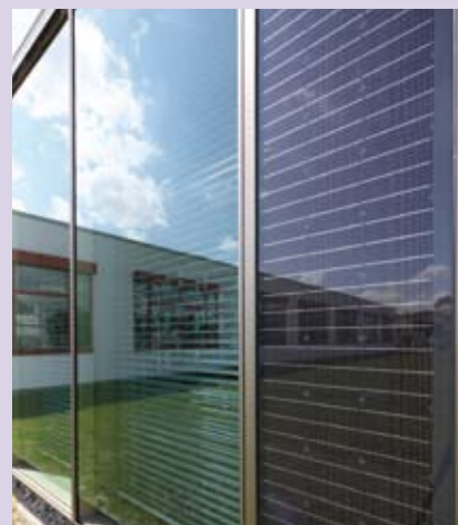
TEMotion är en prefabricerad fasadlösning vilket innebär att det enda man gör på byggarbetsplatsen är att ta upp ett hål i väggen och ersätta befintliga fönster med en ny och energibesparande fasadmodul.
