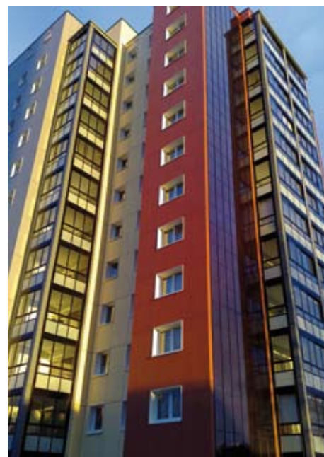
Anneröder Weg, Giessen, Tyskland. Energibesparingar som samverkar; i kombination med inglasade balkonger kläddes delar av fasaden med solpaneler
