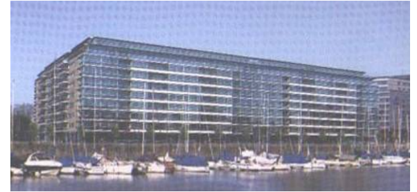
DIQUE IV – Puerto Madero
