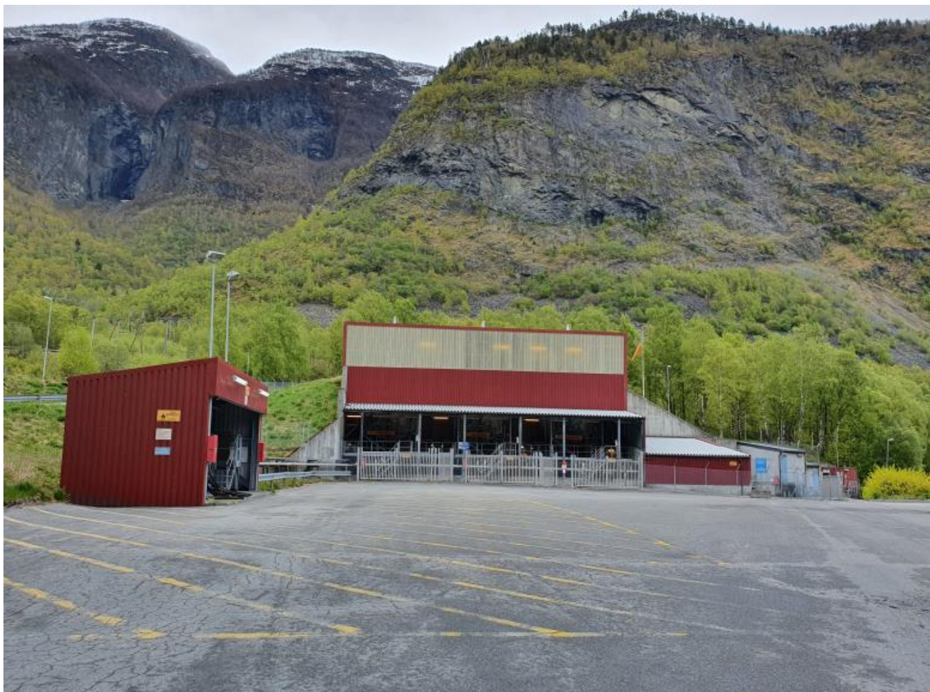
Bilde 3. Fronten ved LPG tankanlegget på Årdalstangen, markert med rød sirkel på Bilde 2. Gule striper markerer EX-sonen rundt fyllestasjonen til venstre i bildet.
