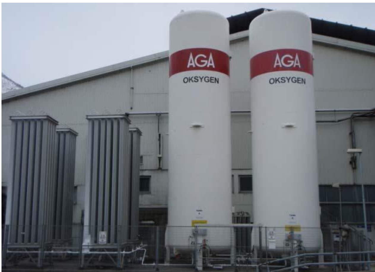
Bilde 4. Oksygentanker i tilknytning til Støperi B. Anlegget eies av Linde gass (tidligere AGA). Bildet viser anlegget når det skal forsyne 2 støpelinjer, pr nå står det kun 1 tank der. Tanken til venstre er fjernet.
