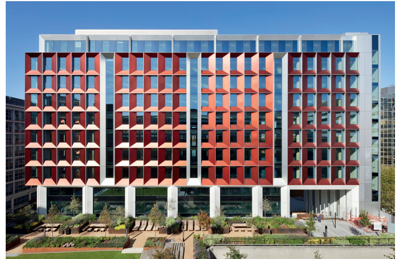
Buzon Pedestal International a fait appel à Hydro EcoDesign pour améliorer les profilés de gouttière, utilisés ici pour le projet Hammersmith à Londres.
