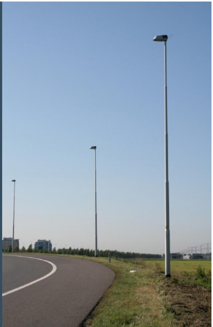
Aufprallfreundliche Lichtmasten in der Energieabsorptionskategorie LE (low energy absorbing). Hierbei handelt es sich um Systeme, die im Falle einer Kollision biegen oder abscheren.
