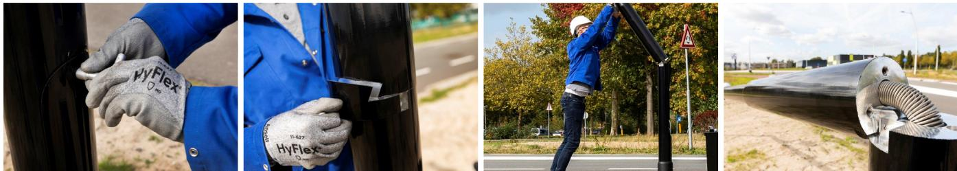
**4 directions de basculement différentes possibles - orientation à définir en fonction du positionnement de la porte**
