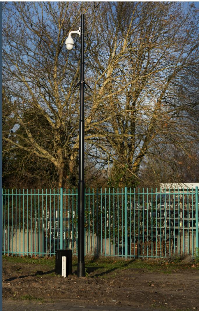
I pali HiLo sono una serie di pali ribaltabili, appositamente concepiti per facilitare l'installazione e la manutenzione dei corpi illuminanti, di telecamere, di sensori, etc.
