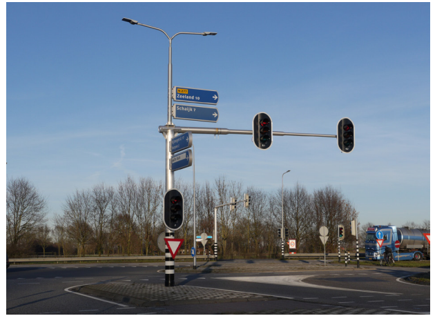
Zweepmast gecombineerd met NBD + OV
