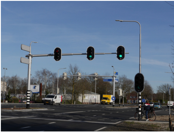
Zweepmast gecombineerd met NBD + OV
