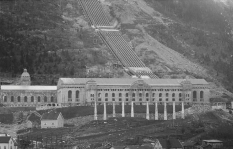
Vemork kraftverk: ligger i Rjukan, Telemark og har vært i drift siden 1911
