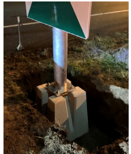
Vorgefertigtes Fundament für eine schnelle Installation
