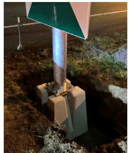
Pre-fab fundatie voor snelle installatie
